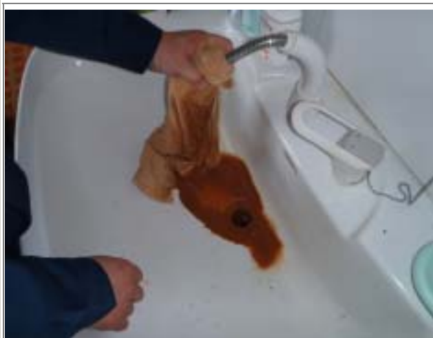
洗面台高周波洗浄中
